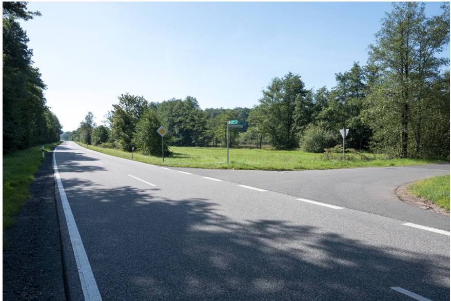
Blick von Nordosten auf den Zufahrtsbereich der L 319
