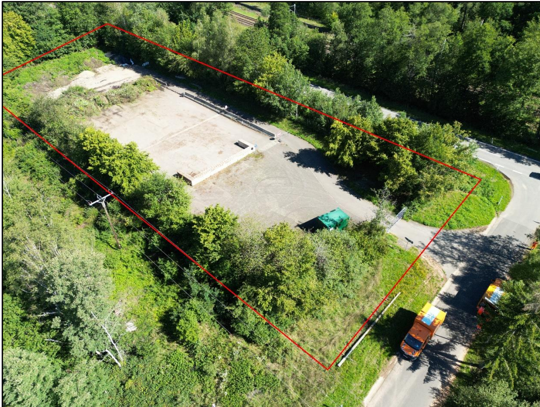
Foto 1: Bestehende Kompostieranlage und Geltungsbereich B-Plan (rot)
